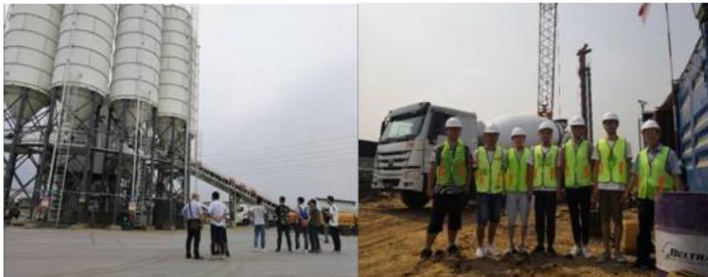
实习队在印尼美加达项目及雅加达—万隆高铁项目现场实践
